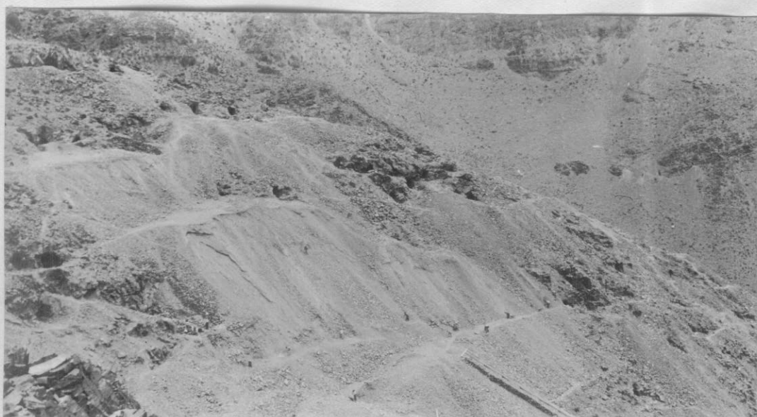
1 - Trabajos en los desmontes de la falda oriental de la "lomita" 3.-
