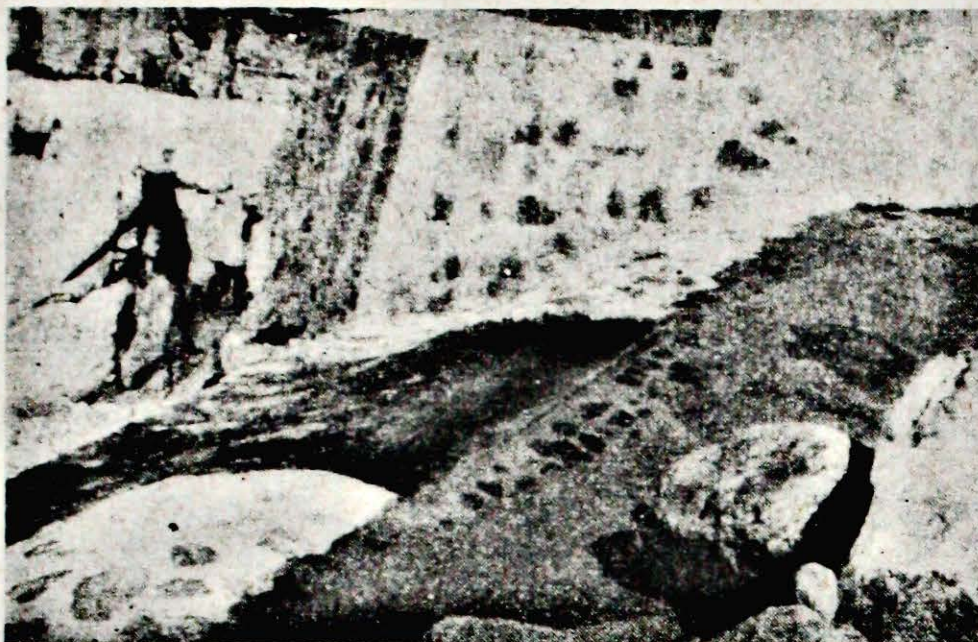
Fot. nº 1. — Elementos de un dique de captación de aguas en el Arroyo Cortaderas
