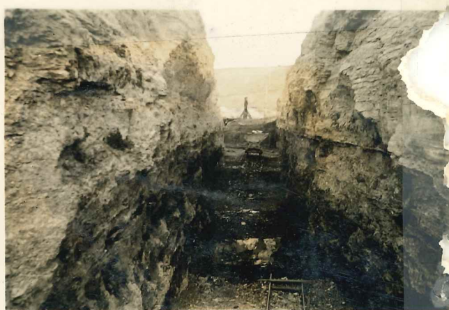
Mina La Escondida. Detalle del corte a cielo abierto en el criadero original entre piques N°3 y N°4. En la punta de rieles se distingue la boca de la primera galería descubierta por el corte. Nótese ausencia de puntales entre los paredones de las cajas.- Ancho de la veta 4m., largo del corte 30m., profundidad reconocida de que aún continúa el mineral, hasta 32m. bajo superficie.
