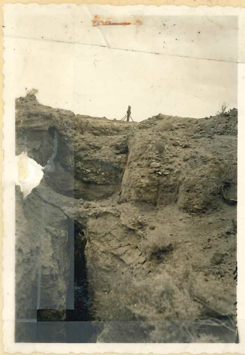
Corte a cielo abierto en el lado Oeste del pique de extracción, parte del cual se ve en la parte superior. Notese falta de apuntalamiento de las paredes donde se ha retirado el mineral.
