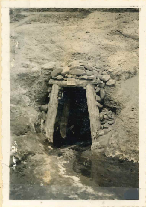
Boca Mina de la galería de desagüe en el flanco oriental del pique de extracción.-
