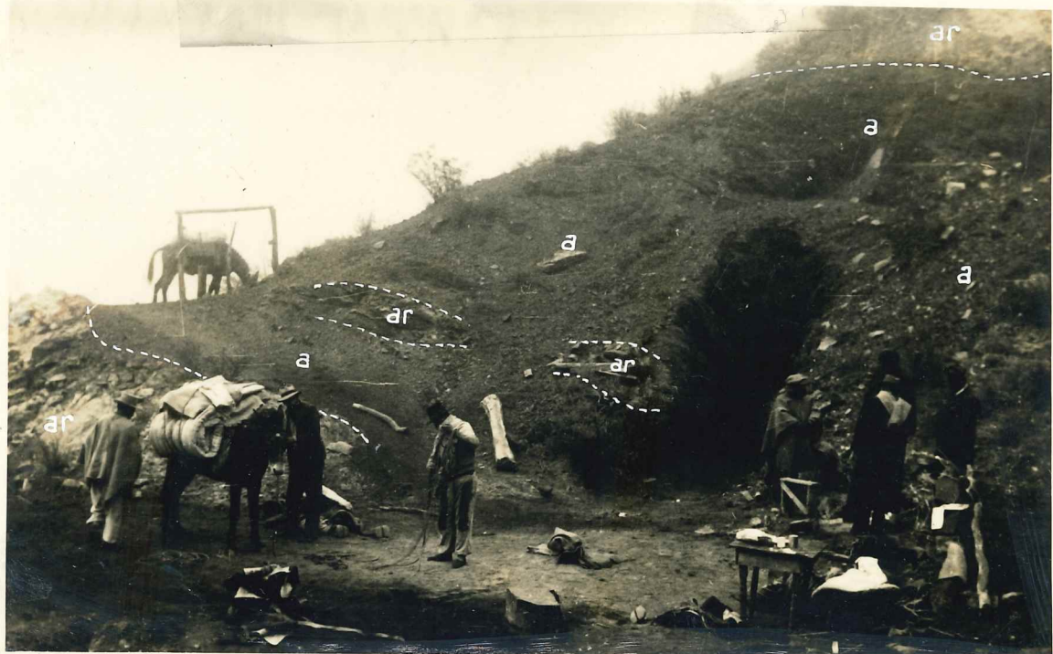
Fot. 2. Trinchera de entrada a la mina Laura, en el extremo norte del campo. A la izquierda areniscas claras más o menos conglomerádicas (ar). Siguen capas arcillosas (a) negruzcas carbonosas con carbón con una intercalación de arenisca (ar) en banco, inclinadas al OSO. y encima nuevamente areniscas claras (ar). Preparando la partida en la mañana del 11 de julio.
