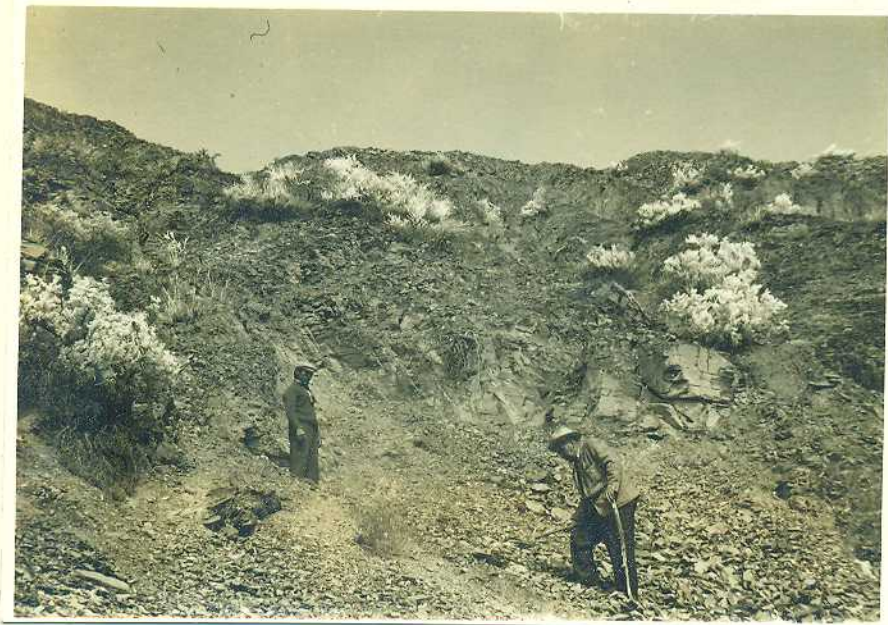
CANCHA MINA Y LABORES DERRUMBADAS
