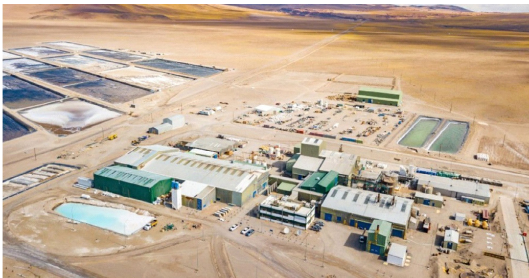
Figura IX.1. Planta de SA ( Selective Adsorption ), carbonato de litio y piletas de evaporación en salar del Hombre Muerto.
