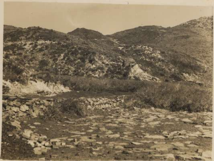
FOTO 7 bis.- Canchas de la vieja planta metalúrgica del mineral de cobre "LA SALAMANCA" - Mendoza.
