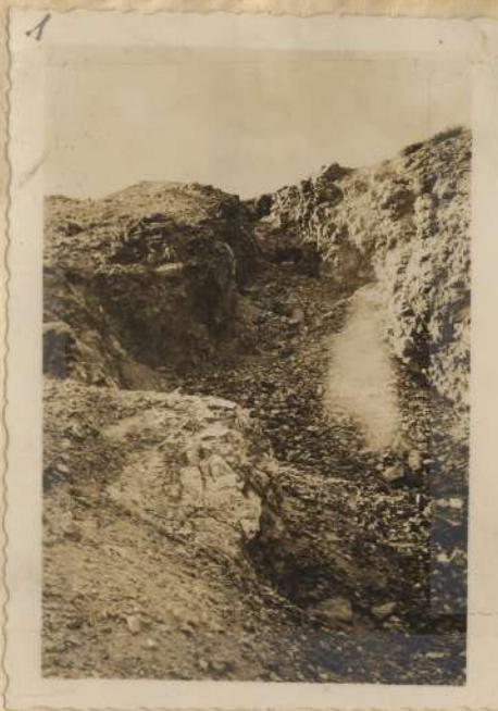
FOTO 1.- "MANTOS DE COBRE" - Labor a cielo abierto - Desmontes y brozas ricas en minerales oxidados (malaquita, azurita, etc.) MENDOZA.
