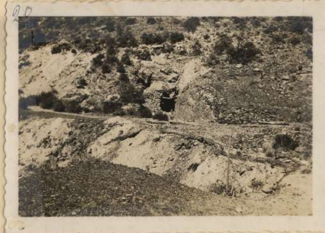
FOTO 20.- Boca de humos del viejo horno metalúrgico de la mina de cobre "LA SALAMANCA" - Ruinas.
