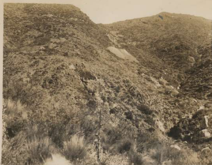
FOTO 3 bis.- Vista del conjunto de las labores y desmontes de la mina "LA SALAMANCA"
