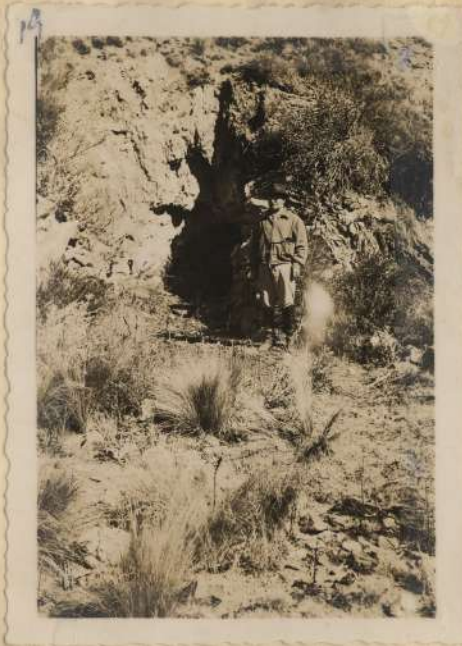
FOTO 19.- Galería abierta en la veta cuprífera de la mina "LA SALAMANCA" - Aparece Dr. L.R.CATALANO.
