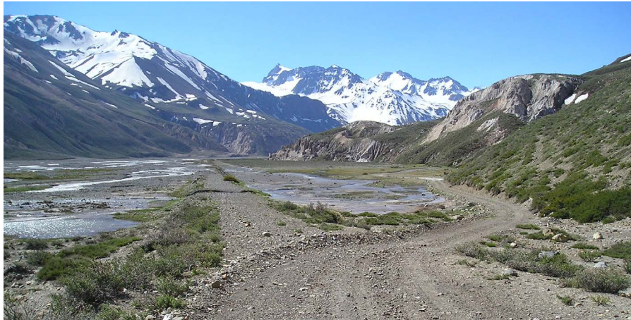
Figura 50. Crecidas y anegamientos que afectan la traza de la ruta provincial 220.
