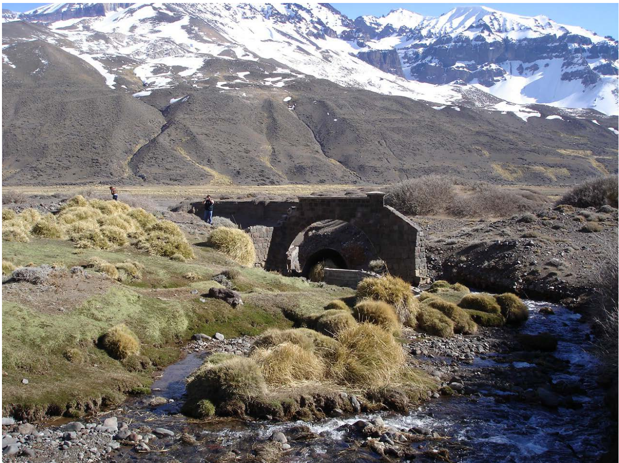
Figura 41. Puente sobre el arroyo Bayo destruido totalmente por la recurrencia de flujos de detritos.
