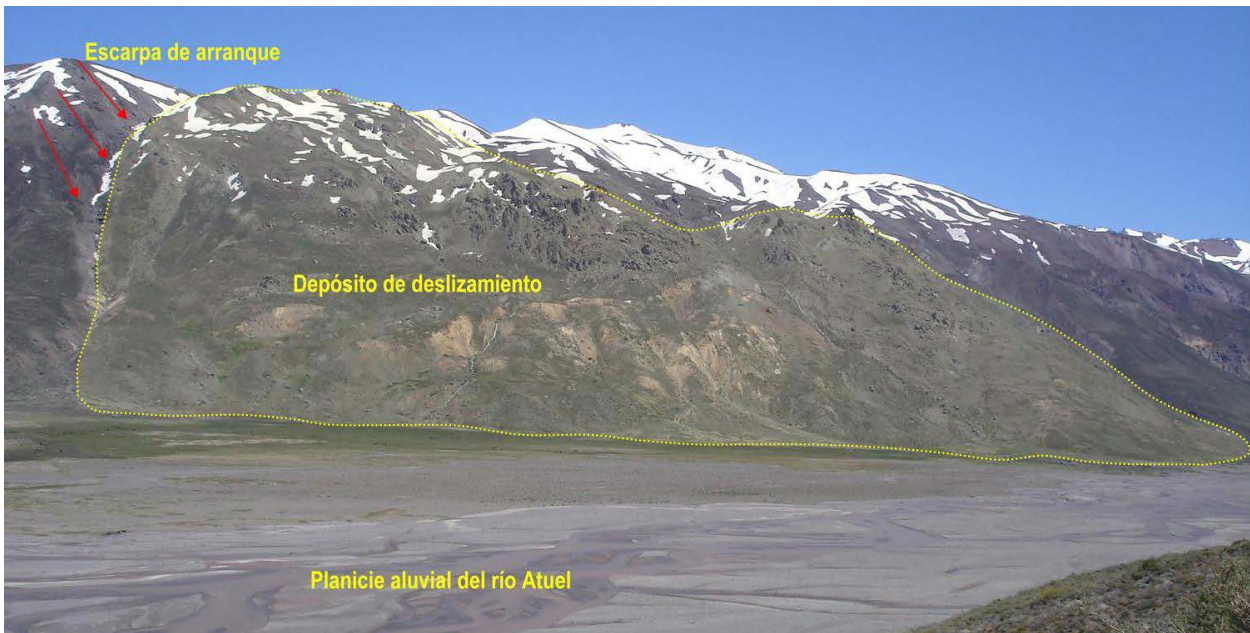
Figura 31. Depósito formado por un deslizamiento ubicado sobre la planicie aluvial del río Atuel, originado en las rocas volcánicas de la Formación Río Damas.
