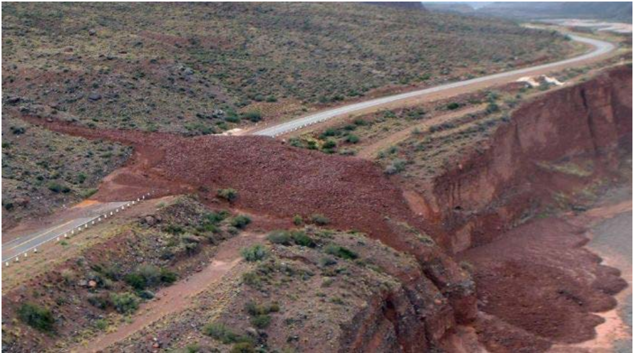
Figuras 38a. Flujo de detritos sobre la ruta nacional 7, febrero de 2013.
