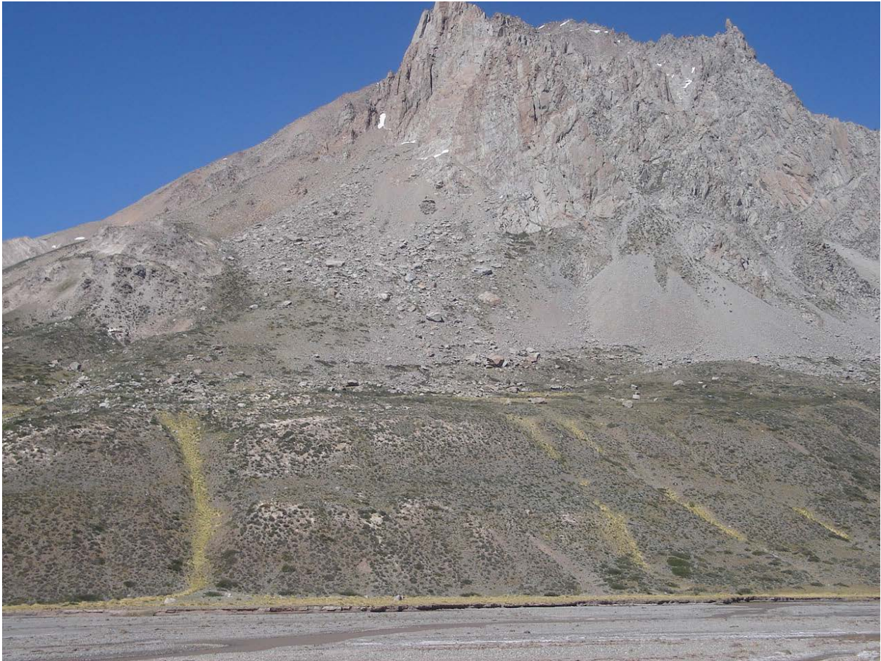
Figura 48. Caídas de rocas procedentes de la ladera norte del cerro de Los Pantanos, ubicado sobre la margen derecha del río Atuel.
