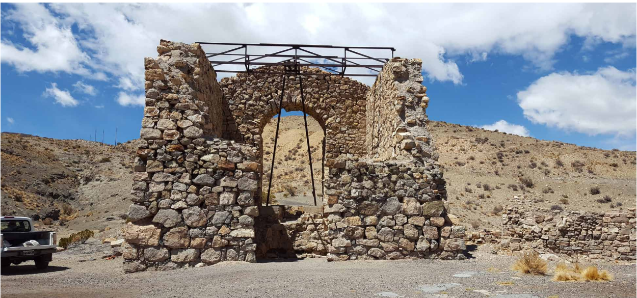
Figura 2.9. Pique Gobernador (60 m de profundidad) construido hacia 1888 (fotografía M. Rosas).
