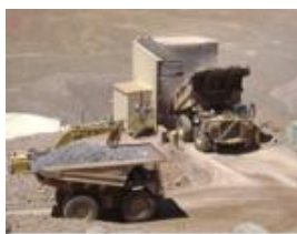
DESCARGA EN TRITURACIÓN PRIMARIA
