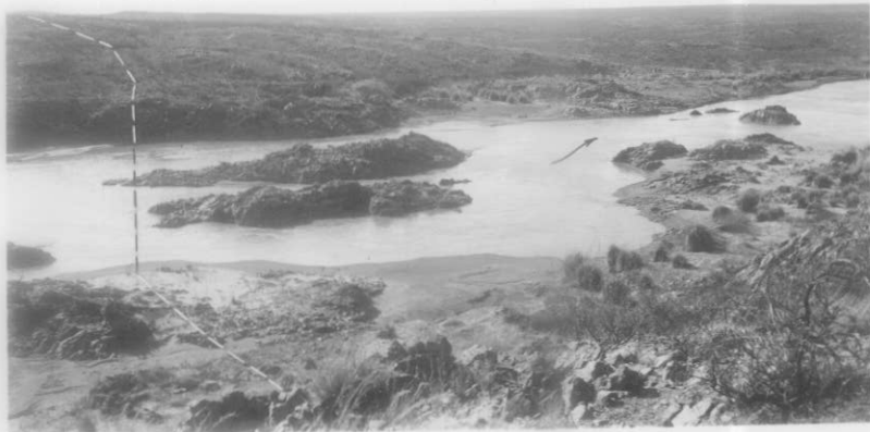
Foto N° 3. — El río Colorado en el lugar de la presa a construirse (segunda solución).
