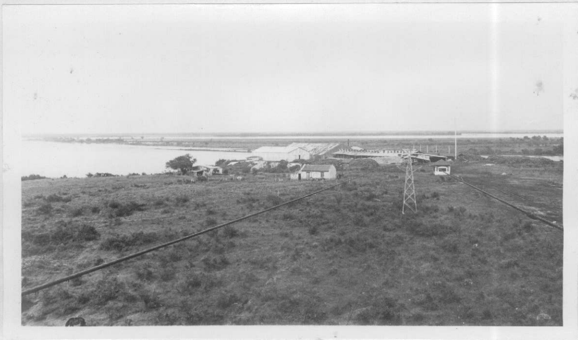
Planta para el tratamiento del material yesífero a orilla del río Paraná en el lugar denominado Puerto Brete.-
