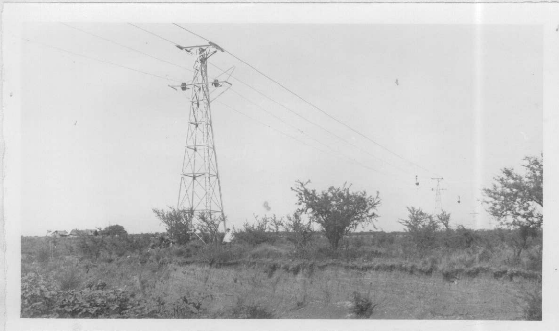
Torres del cablecarril que se utiliza para el transporte del yeso.-
