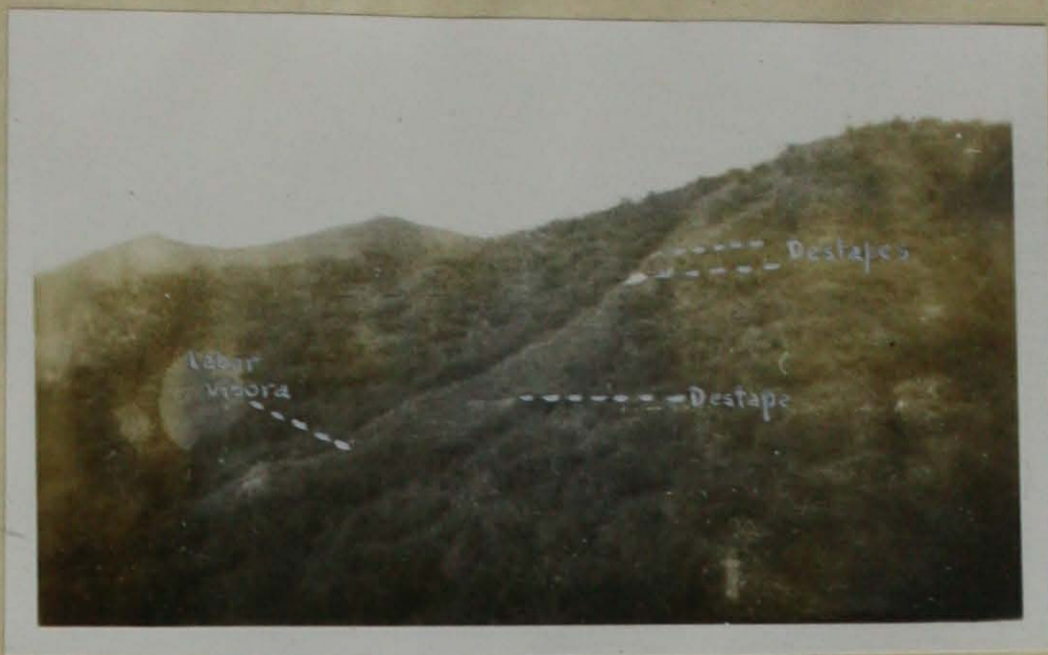
1- Loma Oriental ( falda W), se observan: trabajos de desmonte, destapes y labor "Víbora".
