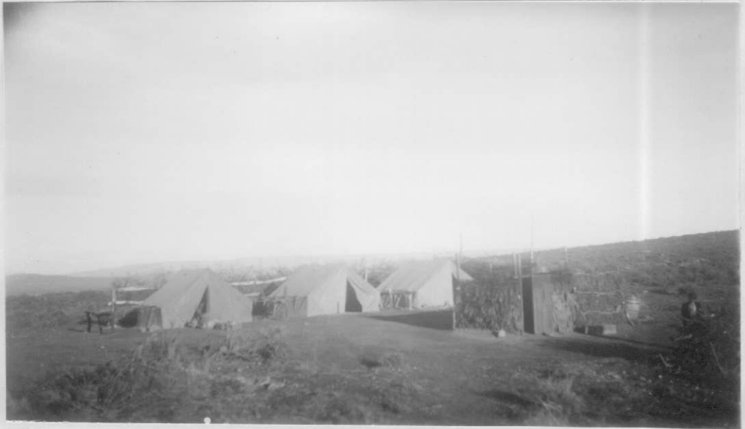
24.522 - Campamento mina "El Porvenir" - Neuquén.-
