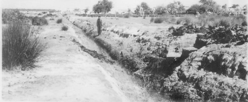
El canal de desagüe del pantano de Toro Yacu, tomado con rumbo al sur, en su parte inferior se observa el estrato de turba terrosa de color negro (1), y encima la capa de ceniza volcánica (2); al fondo Las Termas de Río Hondo.
