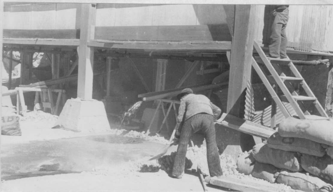
1.- Colada de azufre de un autoclavado; a la derecha, bolsas con azufre refinado.-
