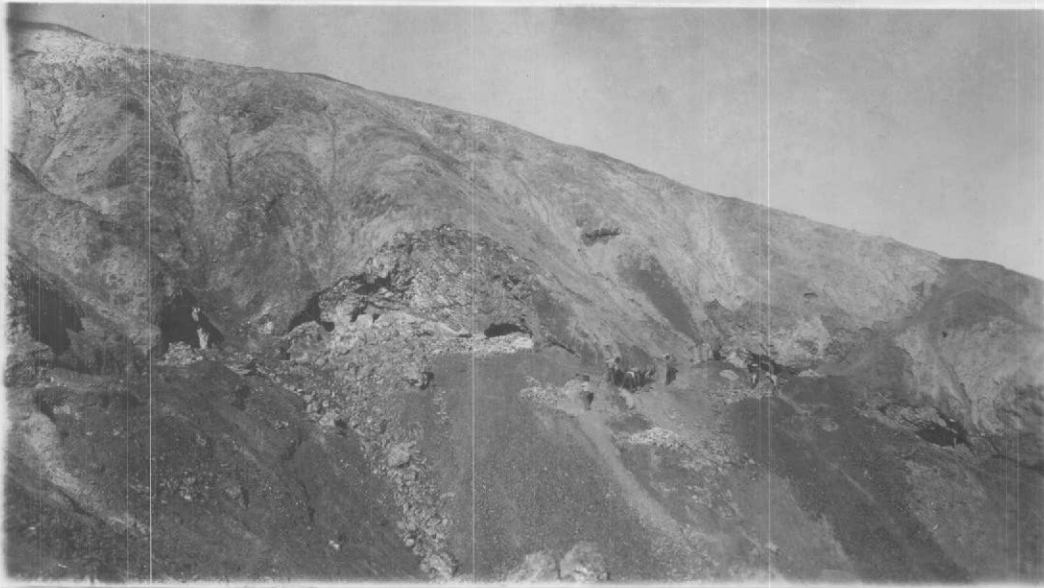
1.- Vista parcial de los trabajos que se efectuan en los depósitos de alumbres en la quebrada del Km 130.-
