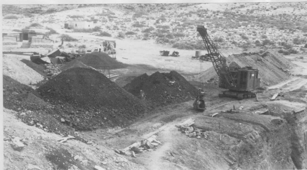
2.- La draga de balde a grampa que extraía la asphaltita del rajo -1939.-
