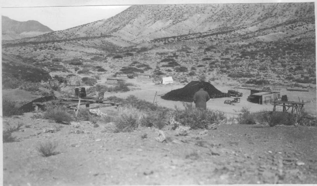
2.- Vista general del campamento de la mina "Santa Marta" en el año 1938. En primer plano las instalaciones de los dos pozos de reconocimiento.
