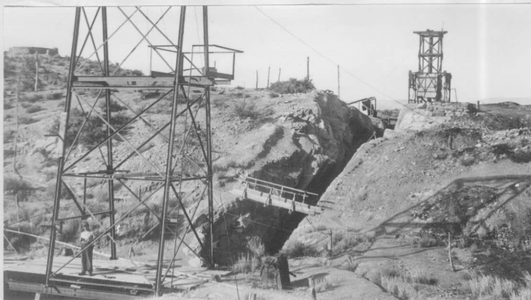
1.- Vista del rajo y de las dos torres de extracción. En primer plano la torre del pozo Zorro; al fondo la del pique Roque.
