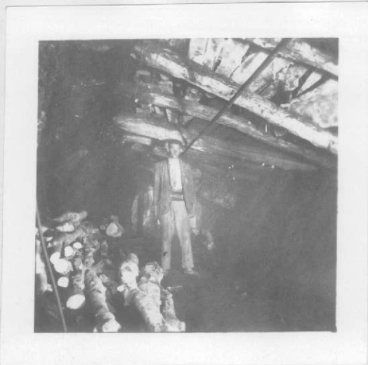
1.-Vista de una labor en el nivel 41 m con su enmaderamiento.
