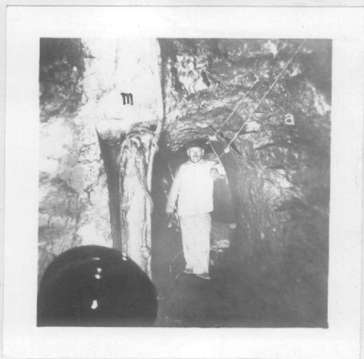
2.- Galería en el nivel 41 m al lado del pique Roque.
