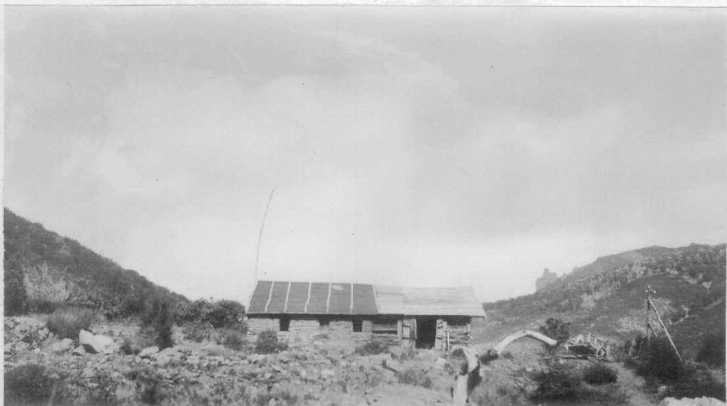
Fot.2.-Mina "María".-Edificio de la Administración.
