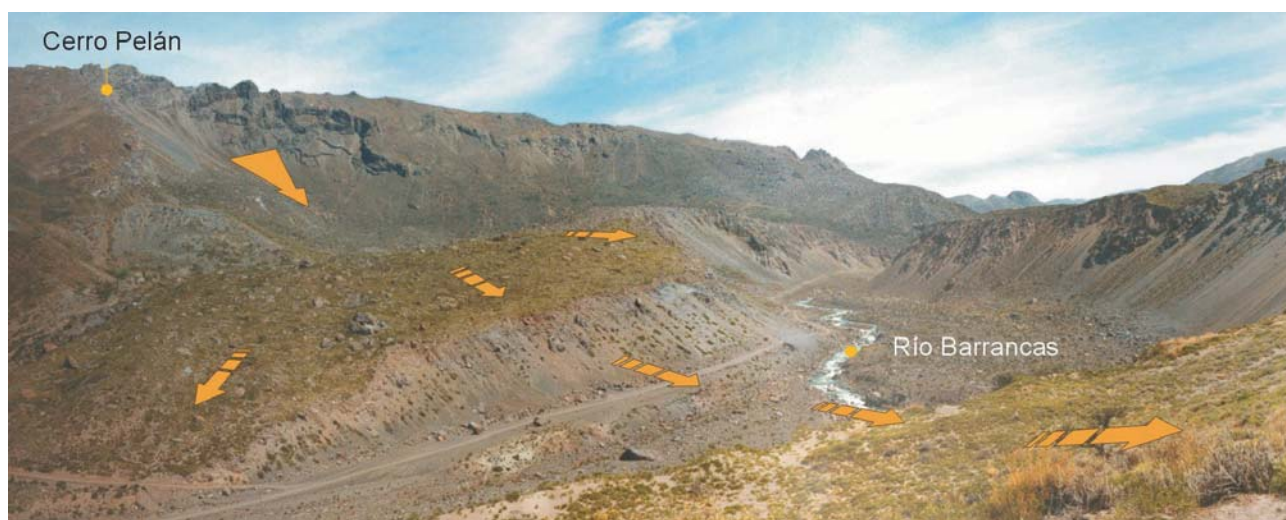
Fotografía 1. Dirección y sentido del movimiento del material procedente desde su desprendimiento en la ladera oriental del cerro Pelán.
