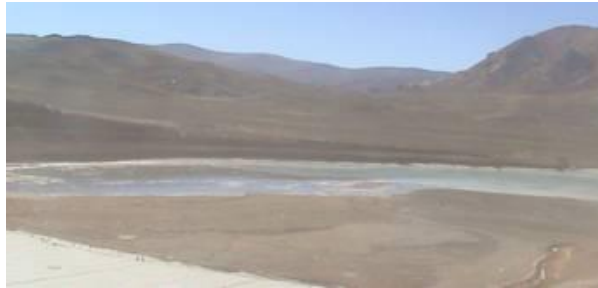
Dique de colas Mina Pirquitas
