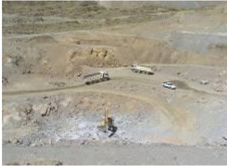
Foto 8: Vista del Open Pit Ampliación Sur
