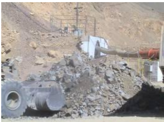
Foto 1: Pila de mineral acopiado en bocamina sector “Oriental”.
