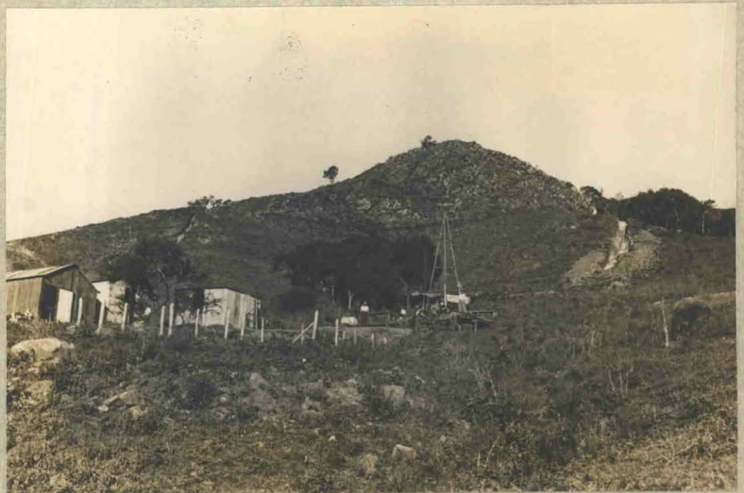
2- Parte central de la zona abra de los Tomates. A am- bos lados de la perforadora "Conrad 23", las labores A 4 y A 5 (trincheras).
