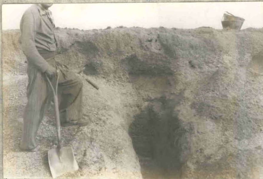
Fig. 4.- Detalle del pozo 7 practicado en el frente con vista al N. Como en el caso anterior, todo el material es aprovechable. Hacia la parte basal se acentúa la relativa estratificación del banco o lente.
