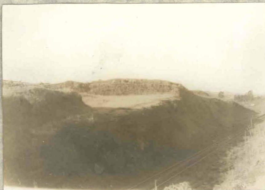
Fig. 6.- Desmonte practicado por el ferrocarril en la roca granítica meteorizada. La superficie iluminada corresponde al sector que puede explotarse de inmediato. Lote 143-Tandil.-
