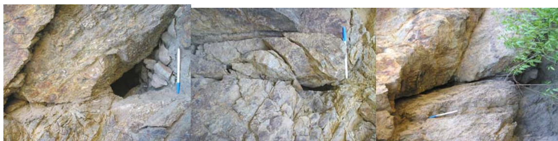
Figura U.L. 10 : Diaclasas juntas, onduladas rugosas, anchas a muy anchas, en la quebrada de la Rioja.
