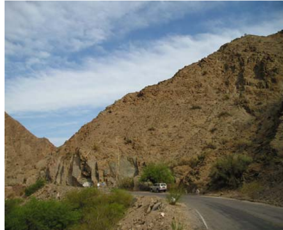
Figura U.L. 5 : Macizo rocoso por el cual atraviesa la ruta N° 60 que pasa por Villa Mazán. Se observan las diaclasas planas lisas, moderadamente juntas y parcialmente abiertas.
