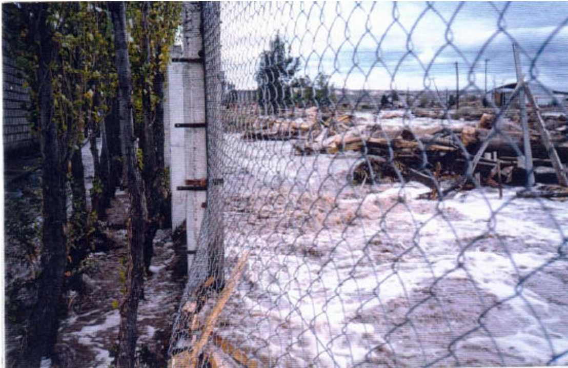
Foto N°46: vista del “aluvión” en su tramo paralelo al alambrado de la Sede Comahue. Los rollizos y maderas provienen del aserradero destruido.
