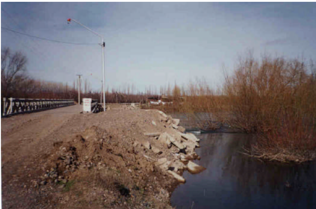
Foto N°37: puente de ingreso a la Isla 19, próxima a Coronel Guerrico. El puente que cruza un brazo del río ha sido reforzado con una escollera.
