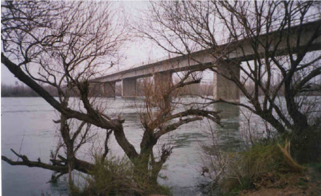
Foto N°34: vista al oeste del puente paso Córdoba, sobre la margen sur del río Negro. Este sector es muy difícil de inundar, ya que la planicie aluvial se encuentra en la margen opuesta.
