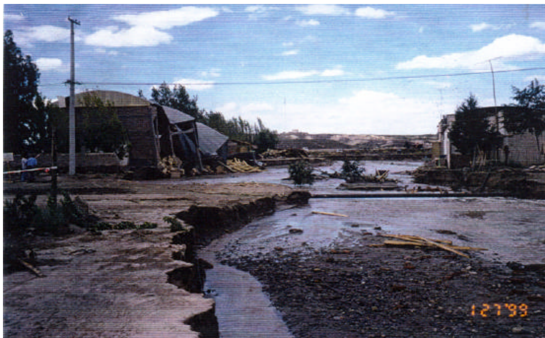
Foto N°45: vista del aserradero “Dos Santos” y los daños sufridos durante el “aluvión”.
