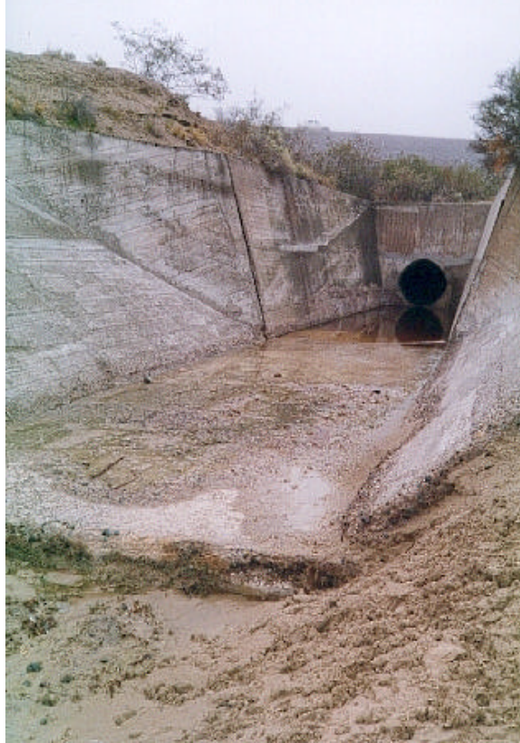
Foto N°39: boca de descarga del “sifón” del dique Roca y el inicio de su canal derivador. Los excedentes se derivaron a través de dicho canal a la presa Catini.
