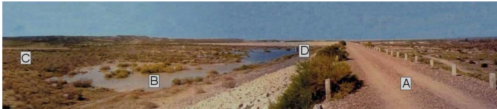
Foto N°43: vista general del dique Catini, 3 meses después del “aluvión” de enero de 1999. (A) camino sobre su coronamiento. (B) las aguas acumuladas corresponden a lluvias y escurrimientos posteriores. (C) ingreso del canal derivador del dique Roca. (D) torreta del “sifón” de descarga del dique.
