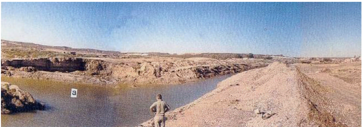
Foto N°40: (a) señala el punto de desembocadura del canal vertedero con el derivador del “sifón” de descarga del dique Catini. Esta defensa secundaria realizada luego del “aluvión” de enero de 1999, interrumpe la continuidad de la cárcava del vertedero.
