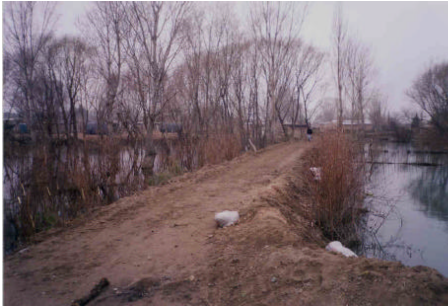
Foto N°25: vista del terraplén que evita la inundación del barrio Paso Córdoba (al este de la ruta provincial N°6). Las aguas a la izquierda de la foto tienen un nivel inferior que el río y pasa por filtraciones.
