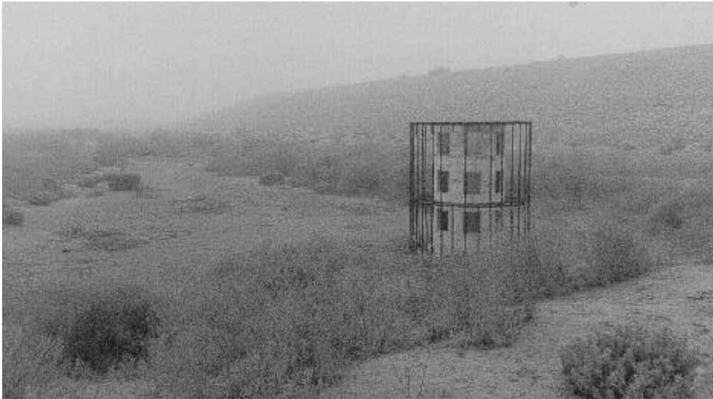
Foto N°41: dique Roca y su “sifón”.
