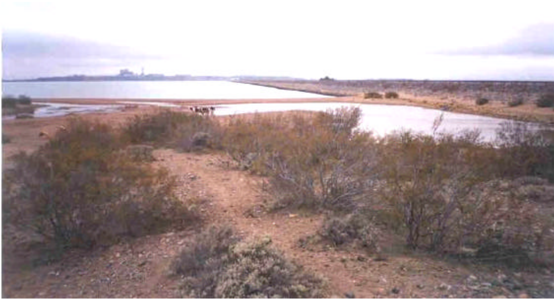
Foto N°19: Represa compensadora Arroyito. Vista de la cota del embalse que se halla en su nivel máximo.
