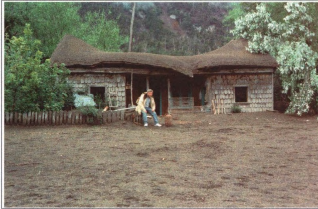
Foto 3: Vivienda afectada por la ceniza volcánica.
