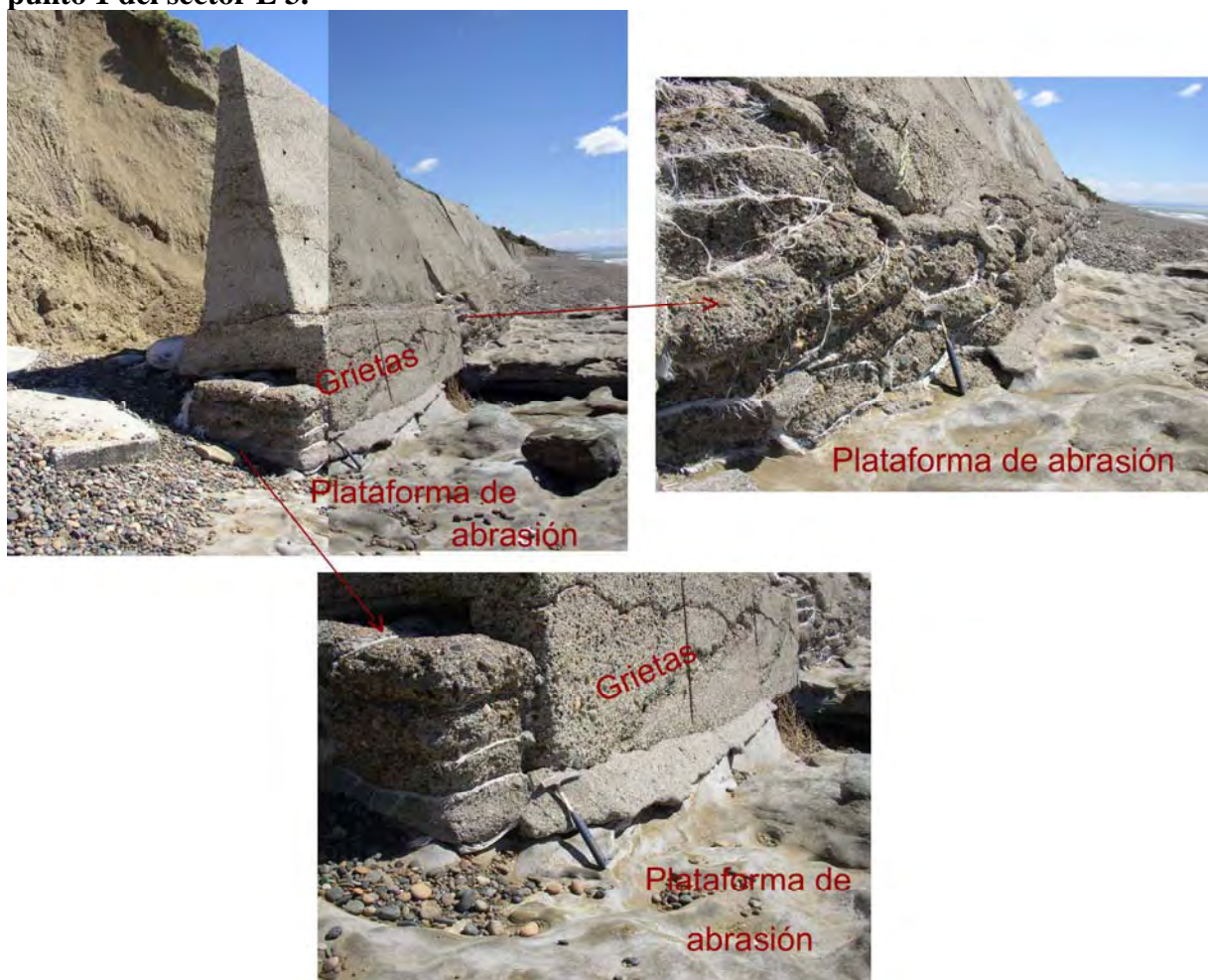
Foto 8: Detalles de la construcción en el II tramo del muro de protección.
