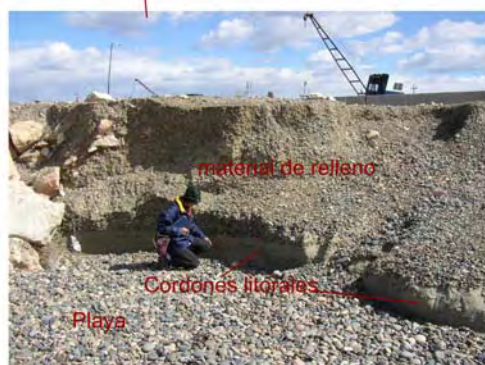
Foto 4: Sector del Puerto Caleta Paula con procesos de erosión marina. Se observa la acción antrópica con el relleno en la costa con gravas y arenas, como de un enrocado de protección para los efectos de la erosión marina.
