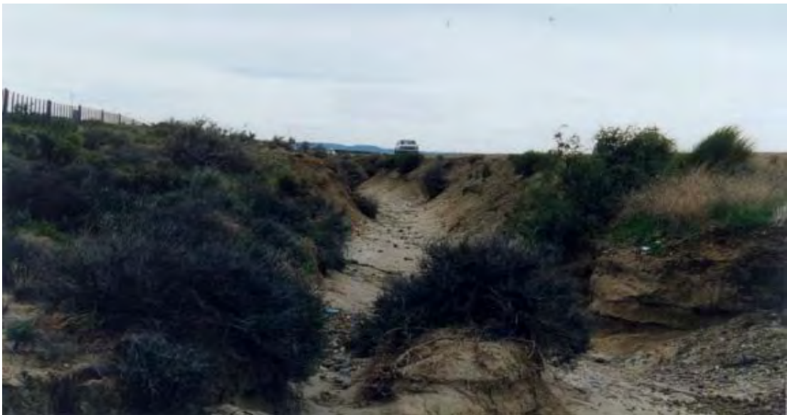
Figura 83: Cárcavas en la Ruta Nacional Nº 3 al Norte de Caleta Olivia
