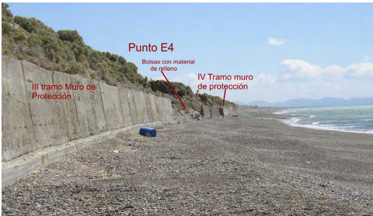
Foto 10: Detalle del tramo III y IV del paredón de protección en el punto E4.
