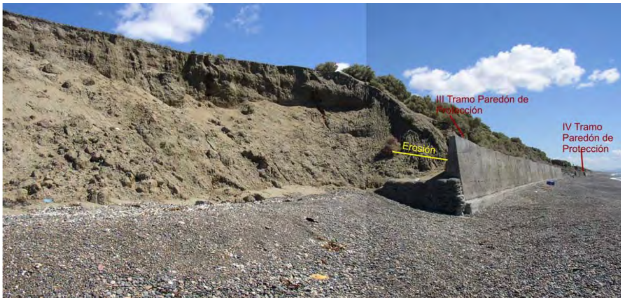
Foto 9: Vista del III y IV tramo del paredón de protección.
