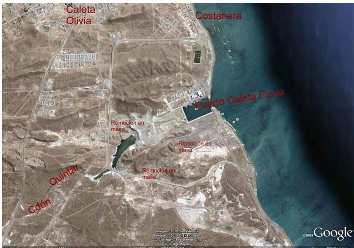
Foto 2: Vista de la imagen Google donde se observan los procesos de remoción en masa en la desembocadura del Cdón Quintar, en las proximidades de la zona del emplazamiento del Puerto Caleta Paula.
