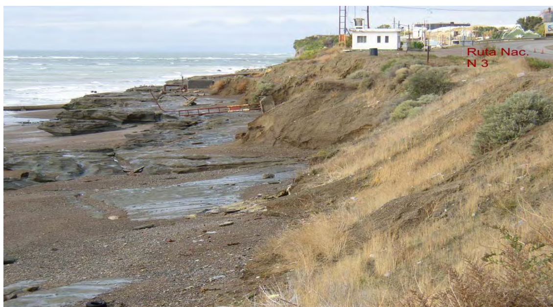
Foto 2: Efectos de la erosión marina en el acceso a la ciudad de Caleta Olivia (Pto1)
