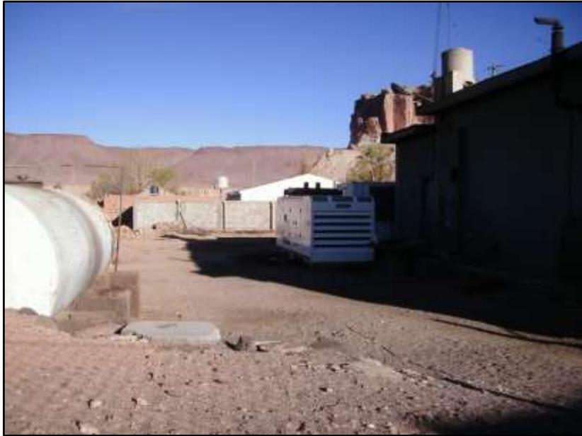
Foto17: se observa un grupo electrógeno de 0.55 MWe que actúa como recambio en turno de madrugada. En el costado derecho se aprecia tanque de gasoil para alimentar los grupos.
