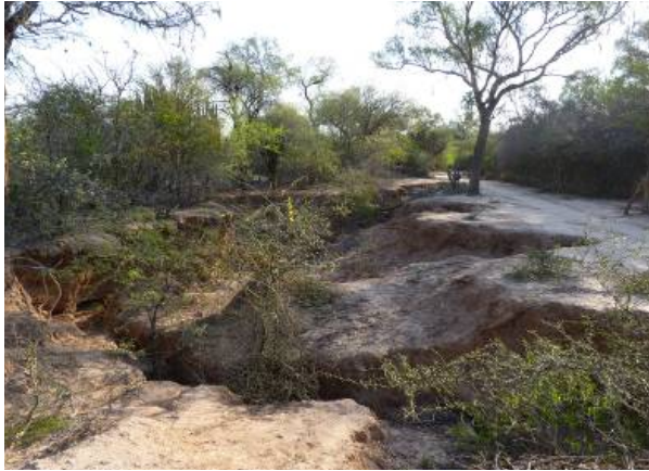
Figura 60: Cárcavas al borde del camino que lleva a Bobadal, localidad ubicada sobre margen oeste del río Itiyuro en su parte distal.
