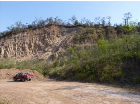
Figura 21: Corte en el borde de la ruta que va a Santa Victoria al este de Campo Duran, se observan bancos de arena y conglomerados que forman un alero mas resistente. Toda la secuencia se encuentra en el flanco occidental de la sierra de Campo Duran. La inclinación de los estratos es hacia el este.
