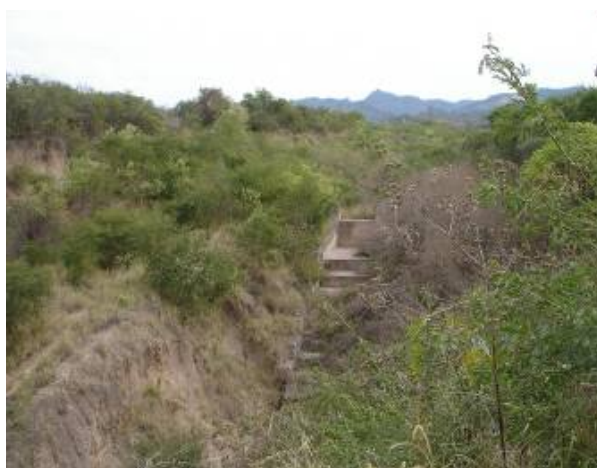
Figura 59: obra de contención en una cárcava ubicada en la cuenca baja del río Lomitas, al oeste de la Ruta Nacional n° 34.
