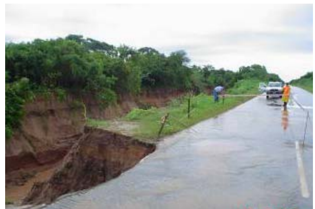
Figura 49: Evento del año 2006 causado por las intensas precipitaciones del verano de este año, cárcava paralela a la ruta Nacional 34, parte de la ruta esta siendo destruida por el agua que proviene de las sierras. (Foto municipalidad de Tartagal)
