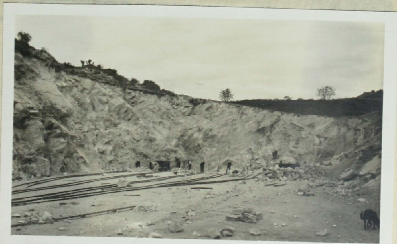
Foto 1.- Vista del frente de la Cantera Chica.-
