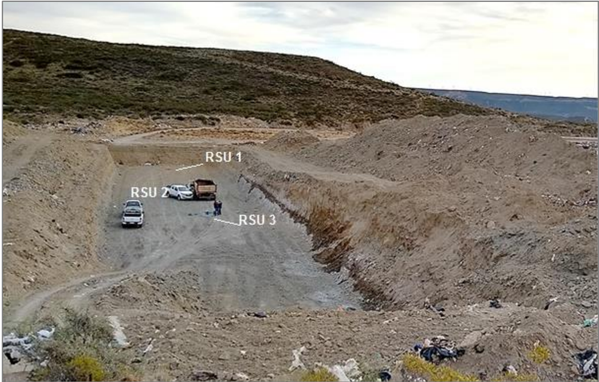
Fig. Nº 3. Vista general de la cava, con la arenisca cinerítica gris claro en los 2/3 iniciales y la arenisca arcillosa que predomina en superficie y en el tramo final. En el talud N-E, de la derecha de la imagen, se observa la presencia de las filtraciones de agua subterránea. Se indican la ubicación de los ensayos RSU1 a RUS3.
