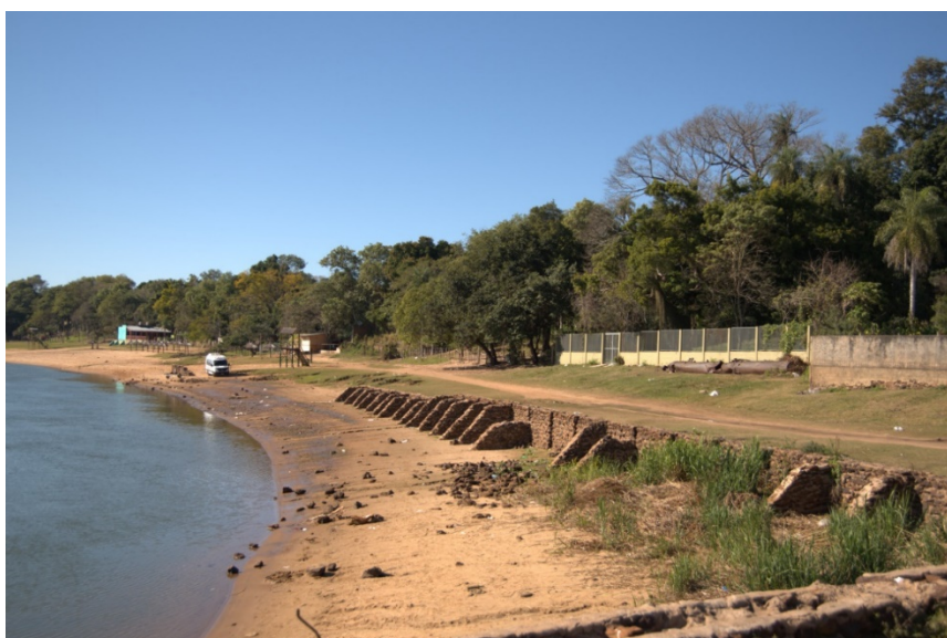
Figura N° 9: Extremo oriental de la defensa de la Av. Costanera de Itatí
