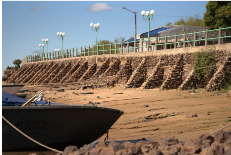
Figura N° 11: Defensa costera a la altura del predio de Prefectura Naval. Posee un moderado grado de preservación, y no presenta riesgo de destrucción inminente, en la medida que se realicen tareas de mantenimiento
