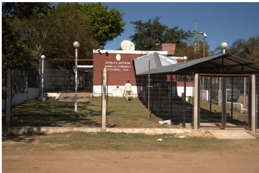
Figura N° 14: Predio de Aduana y Migraciones, desde la Av. Costanera
