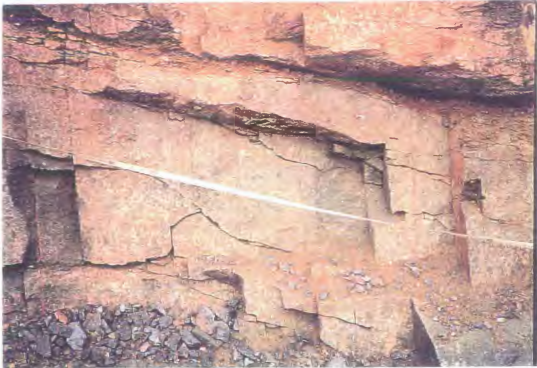
Foto 16.- Fracturas de orientación N10°-20°E, que dan lugar al lajamiento principal de la roca. Transversal Tr-1, Cantera de Julio Marín.
