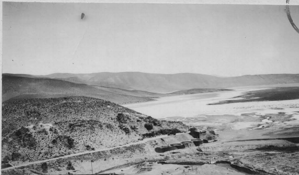
7.- Vista general hacia el N O . En primer término se observan los cuatro tanques de cianuración.-
