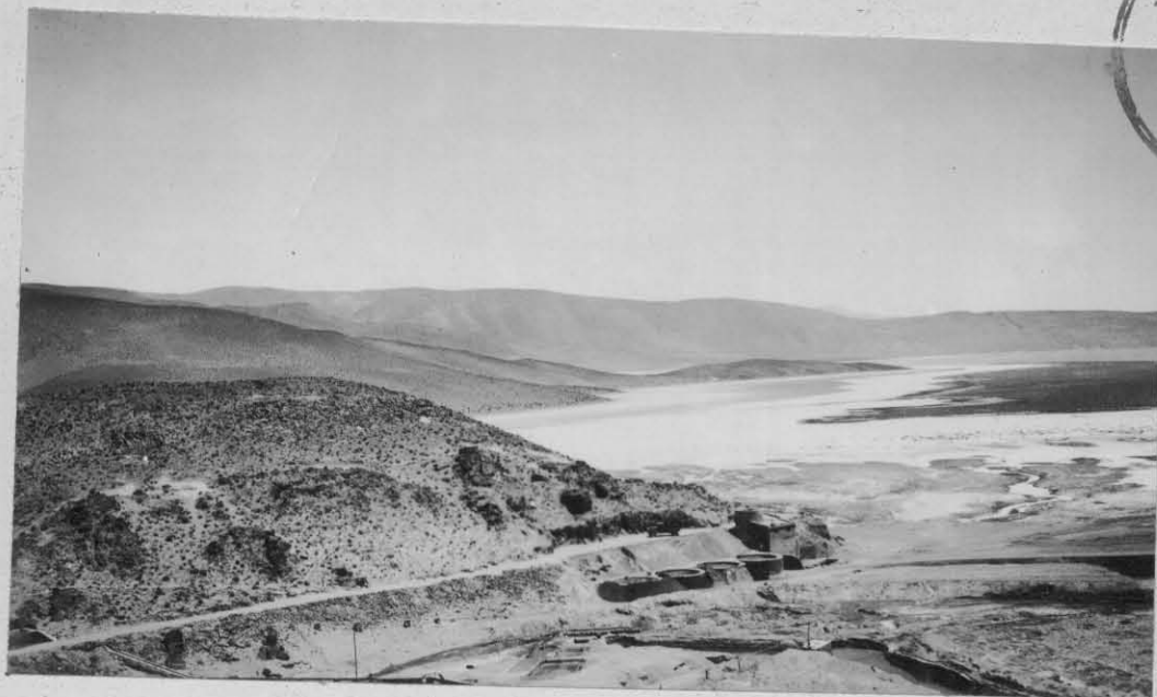
7.- Vista general hacia el N O . En primer término se observan los cuatro tanques de cianuración.-
