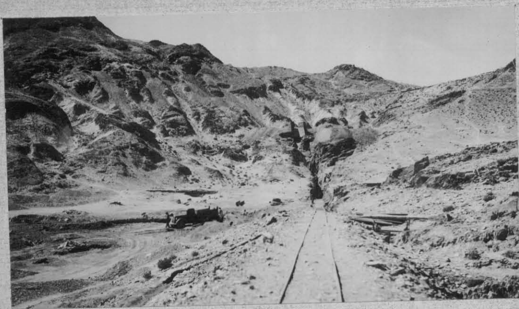
4.- Socavón de entrada a las labores actuales. El decauville conduce el mineral al molino y planta de amalgamación.-
