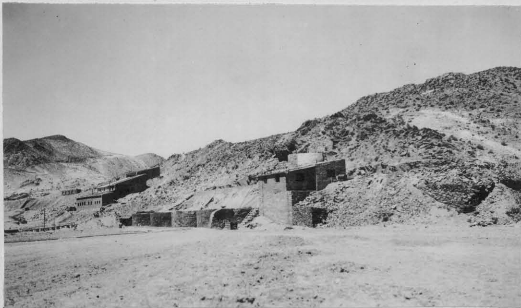
8.- Vista de conjunto, mostrando el molino y planta de amalgamación, a la izquierda, y la planta de cianuración, en primer término.-
