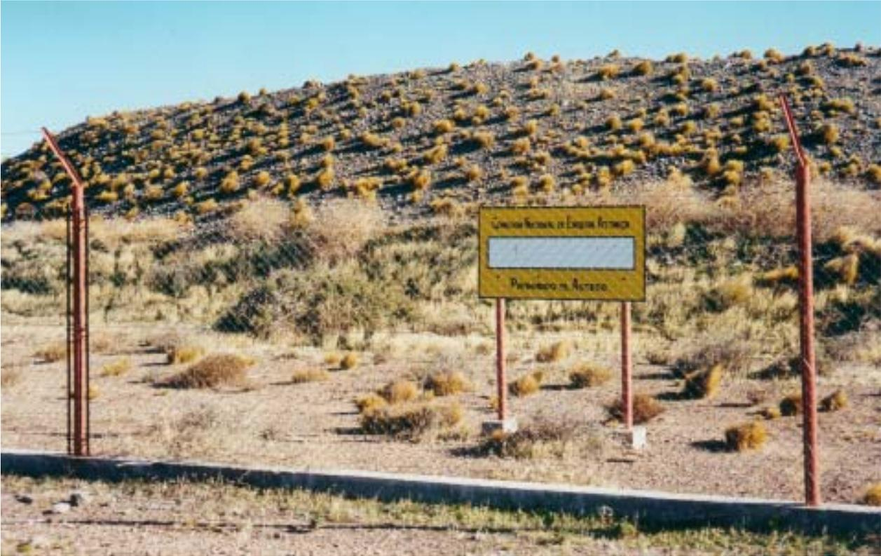
**Foto 22.** Cobertura de las pilas de lixiviación del yacimiento Los Adobes, sobre las márgenes del río Chubut.
