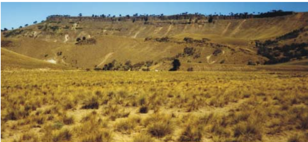
Figura 41. Remoción en masa de la Formación Mitrauquén y el Basalto Tipilihuque en el borde oriental de la Pampa de Lonco Luan, en el río Kilca, al sur del almacén.
