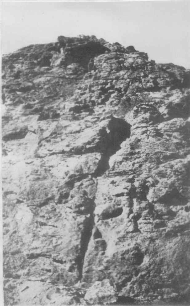
Fot. 2 - Detalle de una diachlase grande, semi-abierta, en el bloque de la margen derecha, entre el eje de la escollera y la pantalla.
