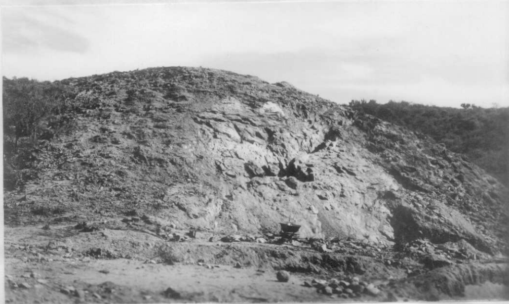
Fot. 1 - Otra vista del bloque del empotre de la margen izquierda, Micacitas con intercalación de micacita fina.
