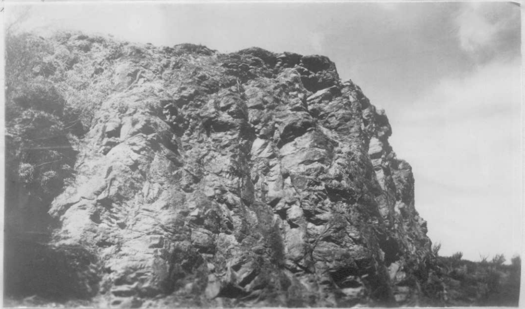
Fot. 1 - Diachlases importantes y continuas de dirección S.35°E que afectan a todo el bloque de la margen derecha, en el lugar del empotramiento.
