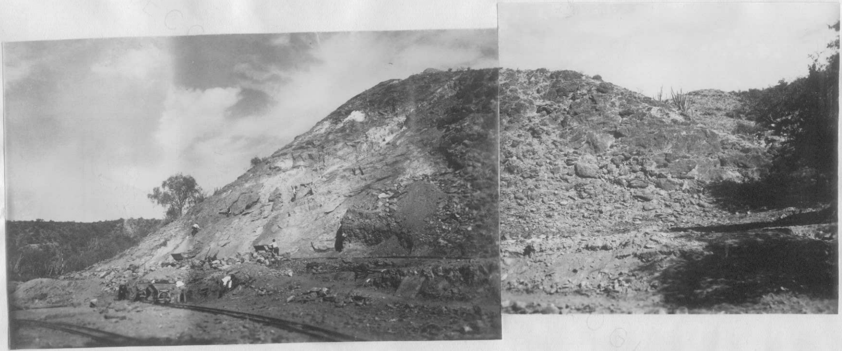
Fot. 1-2 - Bloque de la margen izquierda en el lugar del empotre. Limpieza de la ladera, con el fin de alcanzar la roca fresca. Puede observarse bien la inclinación variable de la misma hacia el arroyo y también diaclasas. La base del jalón marca el nivel del coronamiento. En el extremo derecho, un vallecito alto por donde pasará el vertedero.
