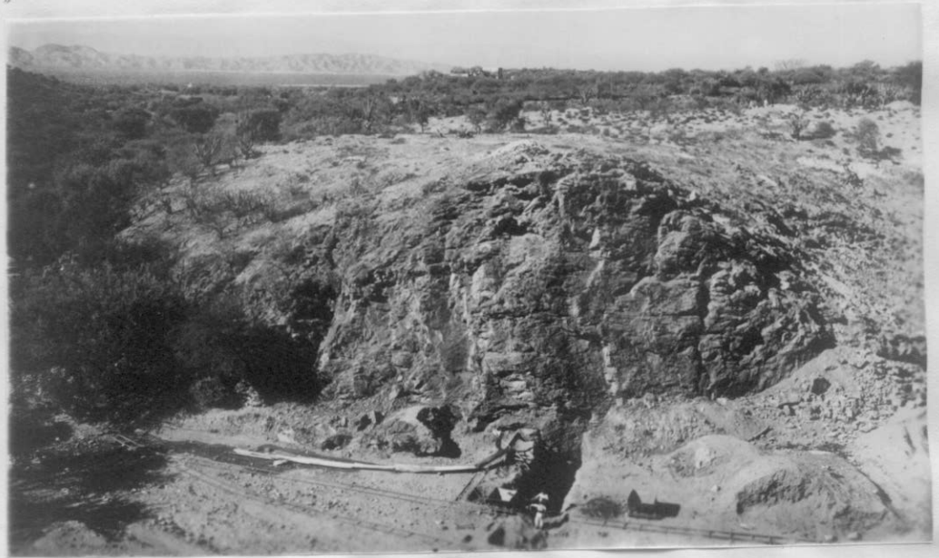
Fot. 1 - Vista del bloque del empotre del margen derecha, desde la margen izquierda. Micacitas con grandes diaclasas.
