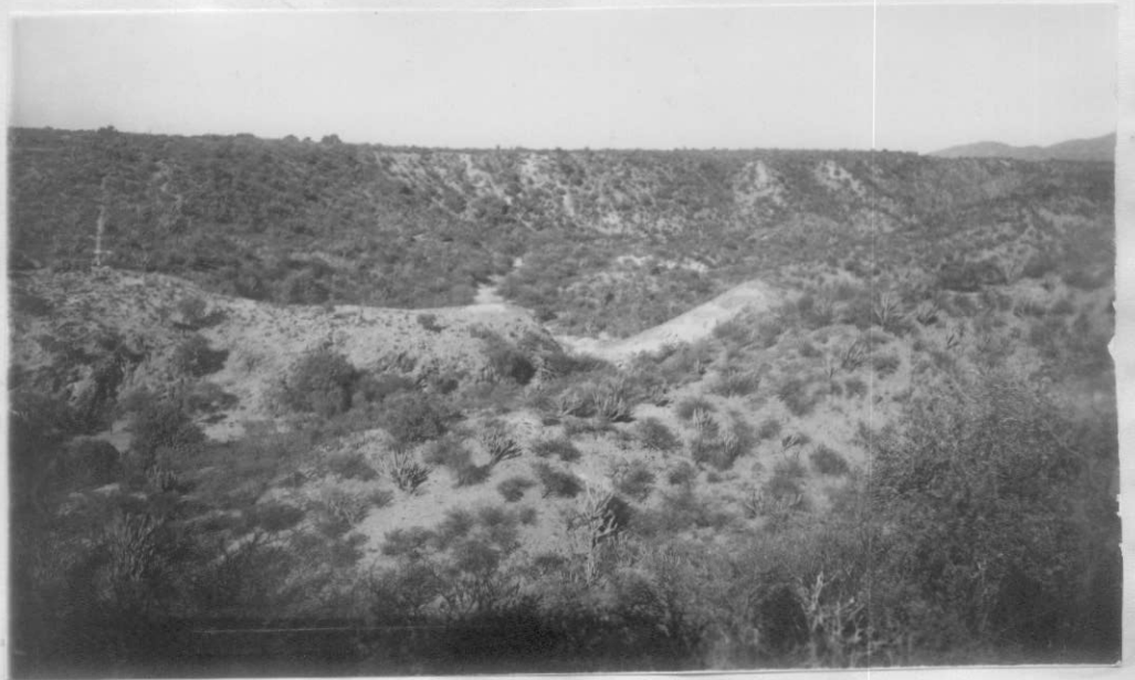
Fot. 2 - Garganta del arroyo de La Florida, lugar del emplazamiento del dique; vista hacia aguas arriba. Terraza alta, parte del pantano, y en el bloque de la margen derecha, pozos de exploración.
