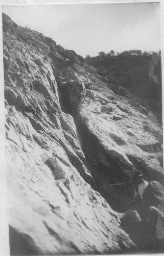
Fot. 2 - Detalle de la excavación de la media falda de la margen izquierda, efectuada para eliminar la micacita fina, blanda, intercalada en micacitas.
